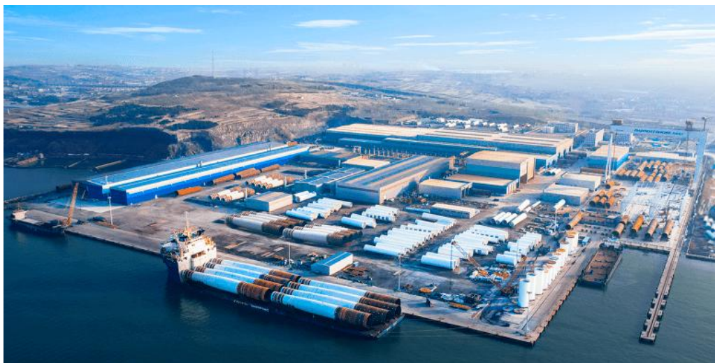
图17：大金重工蓬莱生产基地俯瞰图
